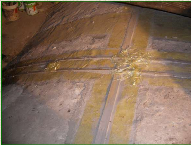
Riparazione e consolidamento statico della Chiesa di S.Matteo di Borgovelino (RI) con materiali compositi a base di fibra aramidica (Anno 2008)
