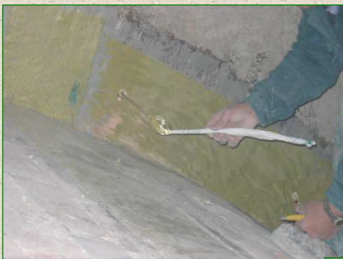
Consolidamento con materiali compositi in fibra aramidica della Chiesa di S. Maria Assunta in Gerano (Roma) (Anno 2003)
