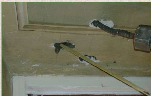
Lavori di consolidamento strutturale della Torre del Circo Romano di Milano mediante utilizzo di materiali compositi a base di fibra aramidica (Anno 2011)
