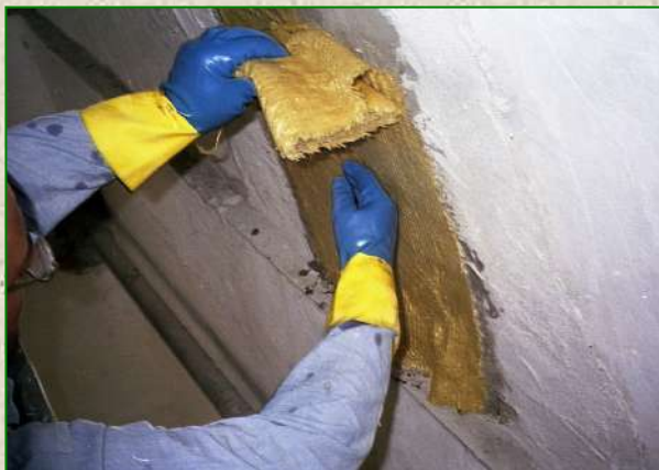
Consolidamento delle volte di Palazzo Farnese in Roma con utilizzo di materiali compositi a base di fibra aramidica (Anno 2005)
