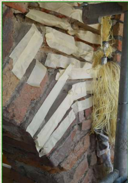
Lavori di consolidamento strutturale della Torre del Circo Romano di Milano mediante utilizzo di materiali compositi a base di fibra aramidica (Anno 2011)
