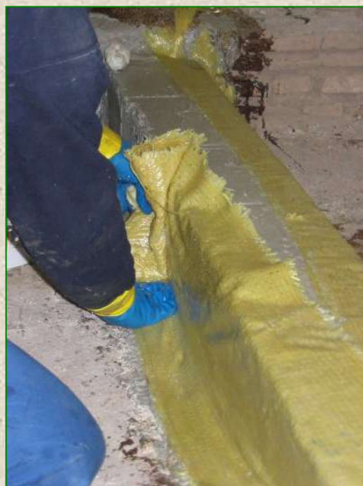
Lavori di consolidamento conservativo ed adeguamento funzionale di un Edificio Scolastico in Roma con utilizzo di materiali compositi a base di fibra aramidica (Anni 2003-2004)
