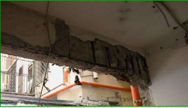
Consolidamento travi in c.a. presso Edificio in Salerno (Anno 2007)
