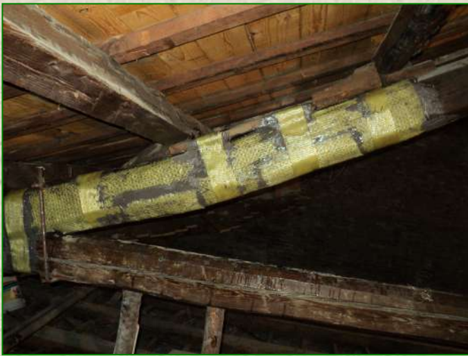
Lavori di consolidamento della Casa di Riposo "Vittorio Emanuele II" in Fabriano (AN) con materiali compositi a base di fibra aramidica - SACEN Composite System A (Anno 2012)
