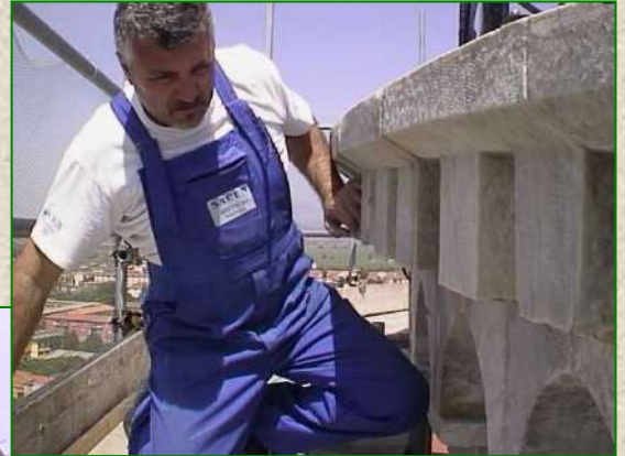
Inghisaggio di frammenti della Torre di Pisa con materiali compositi in fibra aramidica (Anno 2003)
