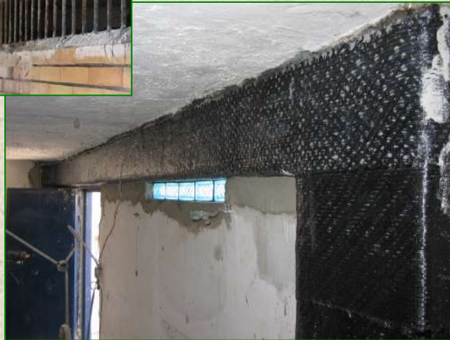
Consolidamento delle volte di Palazzo Farnese in Roma con utilizzo di materiali compositi a base di fibra aramidica (Anno 2005)
