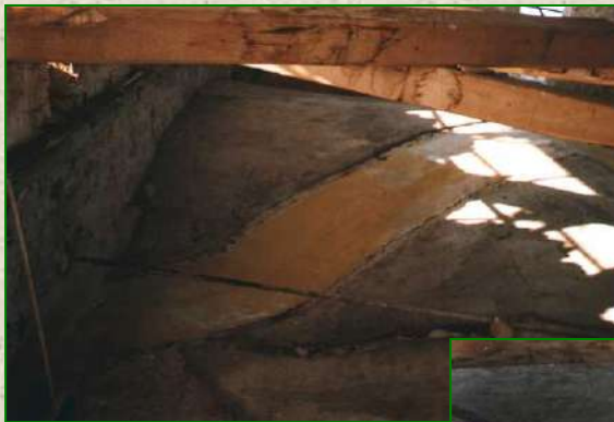
Consolidamento estradosso volte Chiesa S. Michele Arcangelo di Magliano Sabina (RI) con utilizzo di materiali compositi a base di fibra aramidica (Anno 2000)
