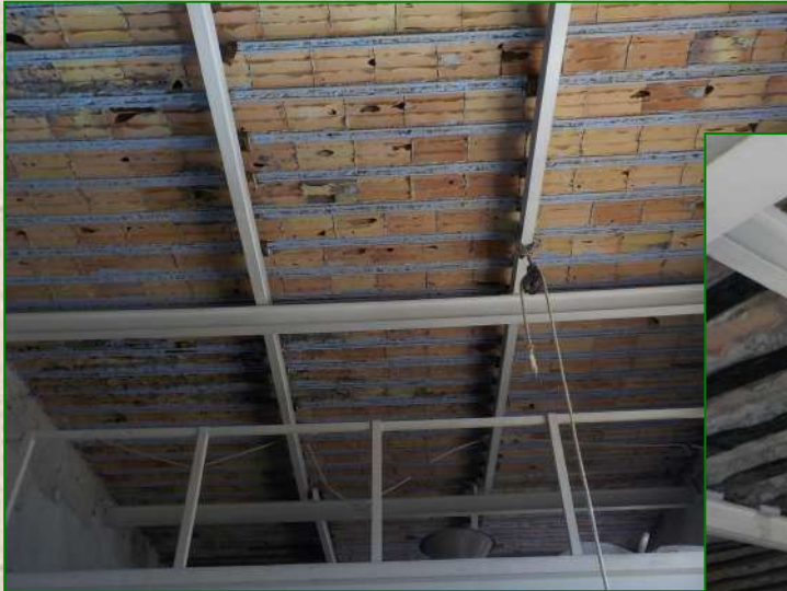
Intervento di risanamento conservativo intradosso solaio terrazzo piano primo con FRP in fibra di carbonio presso edificio in Itri (LT) (2019)
