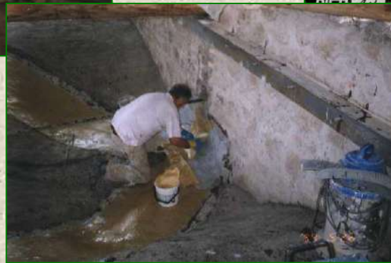
Lavori di consolidamento del frammento di controsoffitto della Domus Aurea in Roma mediante utilizzo di materiali compositi a base di fibra aramidica (Anno 1999)
