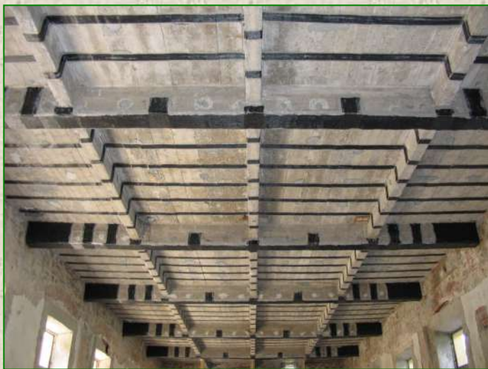
Lavori di consolidamento strutturale solai Ospedale Pediatrico Meyer in Firenze con utilizzo di materiali compositi in fibra di carbonio (Anno 2005)
