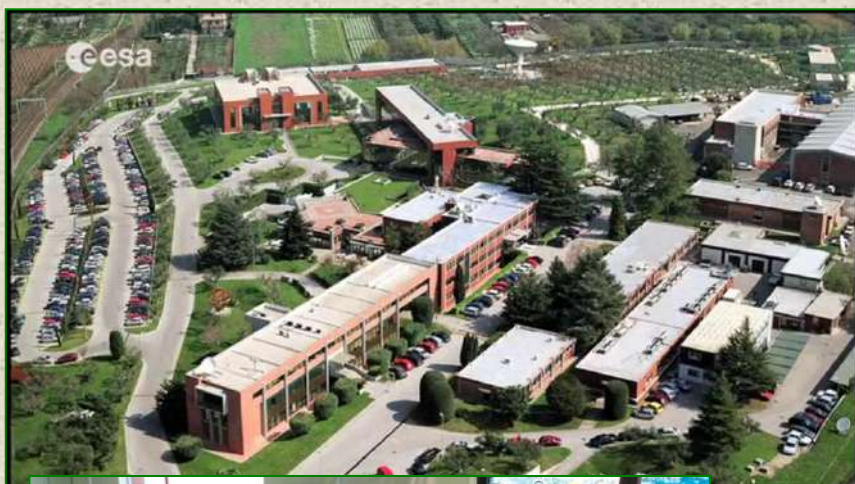
Intervento di rinforzo strutturale nodi trave-pilastro in c.a. presso Edificio B15 Sede Agenzia Spaziale Europea (ESA) in Frascati (Roma) con materiali compositi a base di fibra di carbonio (2016)
