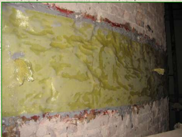
Intervento di consolidamento di pareti in mattoni del Monastero di Santa Margherita in Fabriano (AN) con utilizzo di materiali compositi in fibra aramidica (Anno 2007)
