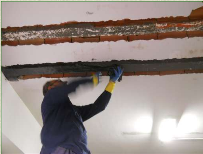
Lavori di rinforzo strutturale di travetti presso locale in Roma, con utilizzo di materiali compositi a base di fibra di carbonio (Anno 2012)
