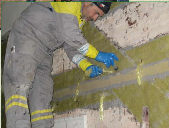
Rinforzo strutturale di piattabande presso la Chiesa di S. Benedetto in Fabriano (AN) (Anno 2009)
