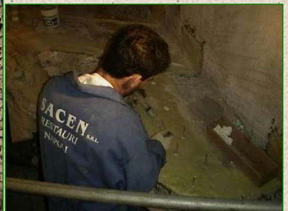
Lavori di consolidamento del frammento di controsoffitto della Domus Aurea in Roma mediante utilizzo di materiali compositi a base di fibra aramidica (Anno 1999)
