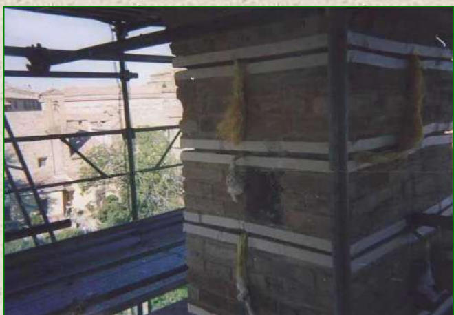
Lavori di consolidamento pilastri mediante utilizzo di materiali compositi presso la Torre Campanaria di Montalcino (SI) (Anno 2006)
