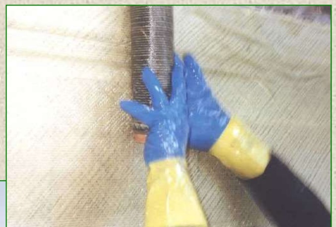
Lavori con impiego di materiali compositi a base di fibra aramidica e carbonio per la disarticolazione e rimozione della Stele Obelisco di Axum in Roma (Anno 2003)
