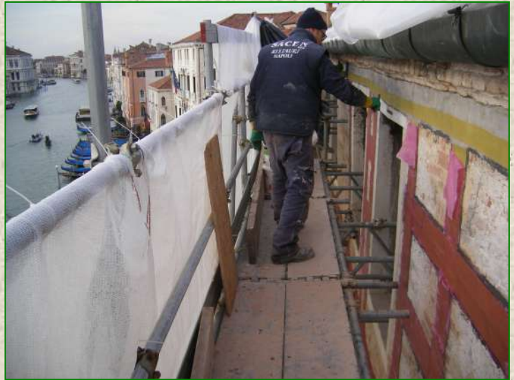
Lavori di rinforzo strutturale con materiali compositi a base di fibra aramidica presso edificio prospiciente il Canal Grande in Venezia (Anno 2010)
