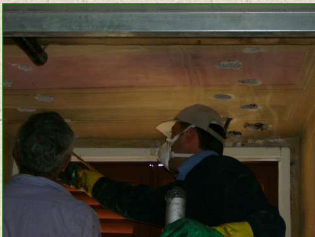
Lavori di consolidamento architravi presso la Curia Vescovile in Frascati mediante utilizzo di materiali compositi a base di fibra aramidica (Anno 2011)
