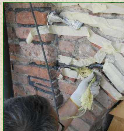
Lavori di consolidamento strutturale della Torre del Circo Romano di Milano mediante utilizzo di materiali compositi a base di fibra aramidica (Anno 2011)
