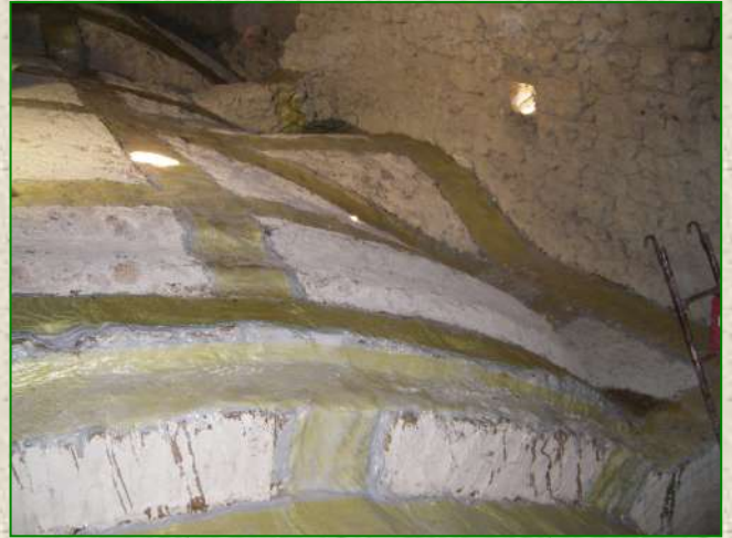
Lavori di consolidamento dell'impianto voltario della Chiesa S. Maria Assunta in Poggio Mirteto (RI) con utilizzo di materiali compositi in fibra aramidica (Anno 2007)
