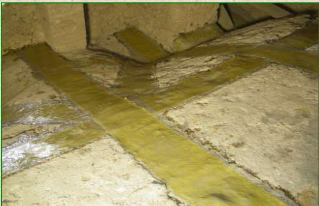
Intervento di consolidamento di pareti in mattoni del Monastero di Santa Margherita in Fabriano (AN) con utilizzo di materiali compositi in fibra aramidica (Anno 2007)
