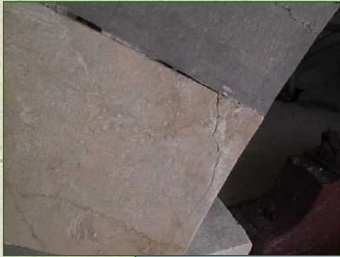
Inghisaggio di frammenti della Torre di Pisa con materiali compositi in fibra aramidica (Anno 2003)
