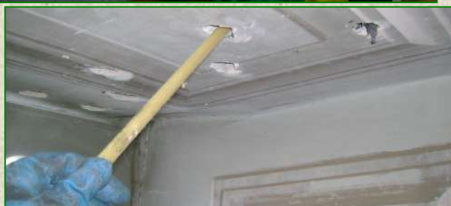
Lavori di consolidamento strutturale della Torre del Circo Romano di Milano mediante utilizzo di materiali compositi a base di fibra aramidica (Anno 2011)
