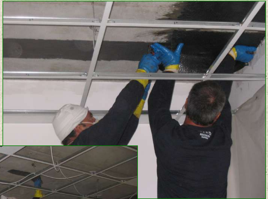
Intervento di rinforzo della Scuola media Gentile in Fabriano (AN) con tessuto a base di fibra di carbonio (Anno 2009)
