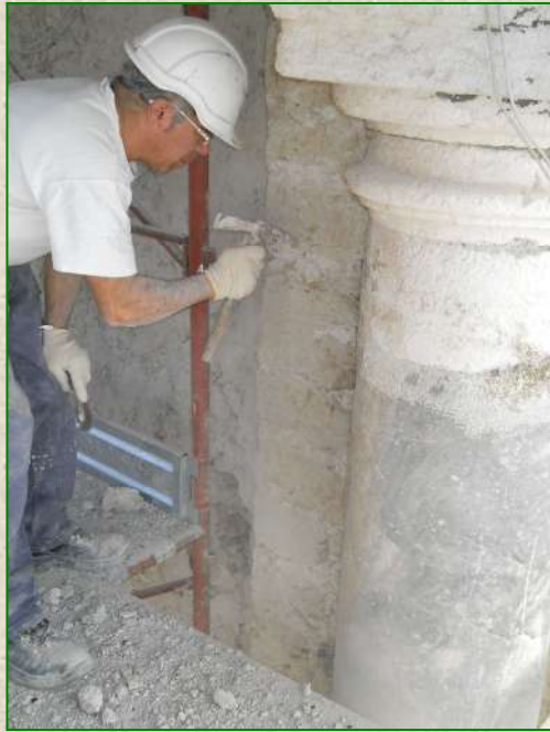
Lavori di consolidamento della "Porta dei Cappuccini" in Sessa Aurunca (CE) con impiego di materiali compositi in fibra aramidica metodo "SACEN Composite System A" (Anno 2012)
