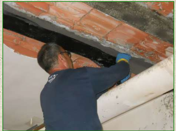
Lavori di rinforzo strutturale di travetti presso locale in Roma, con utilizzo di materiali compositi a base di fibra di carbonio (Anno 2012)
