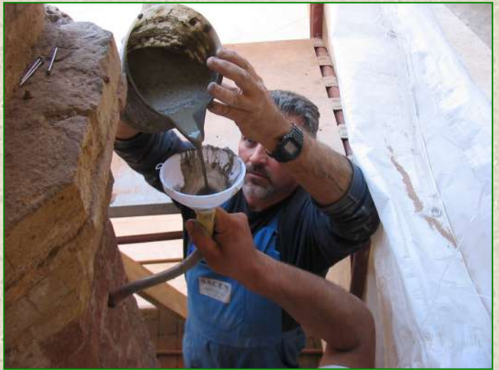
Lavori di rinforzo strutturale dei pilastri in muratura presso il Museo della Carta in Fabriano con utilizzo di materiali compositi in fibra aramidica (Anno 2005)
