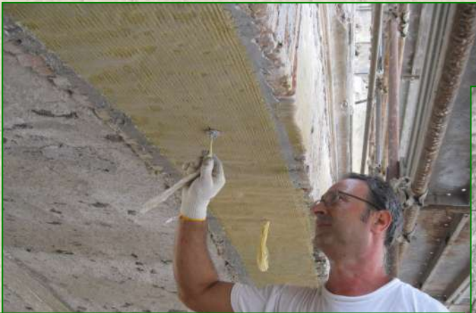
Consolidamento del Ponte di collegamento del Compendio della SS. Annunziata in Gaeta con impiego di materiali compositi a base di fibra aramidica (Anno 2009)
