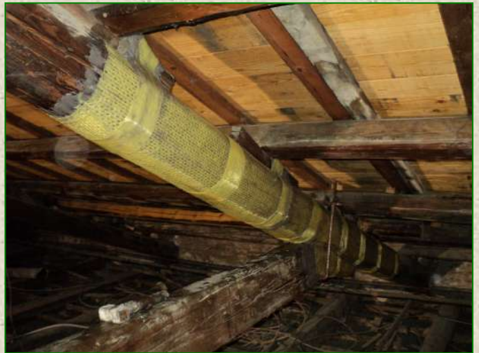
Lavori di consolidamento della Casa di Riposo "Vittorio Emanuele II" in Fabriano (AN) con materiali compositi a base di fibra aramidica - SACEN Composite System A (Anno 2012)
