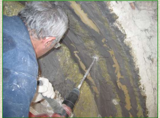
Lavori di consolidamento della "Porta dei Cappuccini" in Sessa Aurunca (CE) con impiego di materiali compositi in fibra aramidica metodo "SACEN Composite System A" (Anno 2012)
