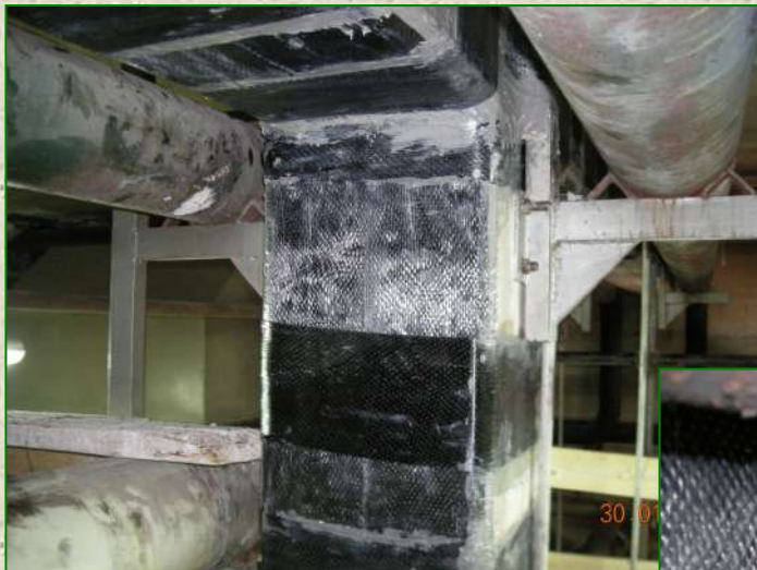
Consolidamento solaio Ospedale Cardarelli in Napoli, con materiali compositi a base di fibra di carbonio (Anno 2008)
