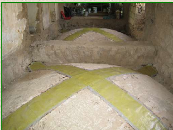
Lavori di consolidamento pilastri mediante utilizzo di materiali compositi presso la Torre Campanaria di Montalcino (SI) (Anno 2006)
