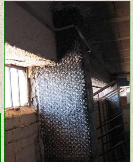
Lavori di consolidamento di struttura balneare in cemento armato con utilizzo di materiali compositi a base di fibre di carbonio – (Anno 2005)
