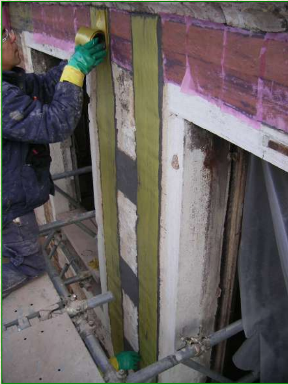
Lavori di rinforzo strutturale con materiali compositi a base di fibra aramidica presso edificio prospiciente il Canal Grande in Venezia (Anno 2010)
