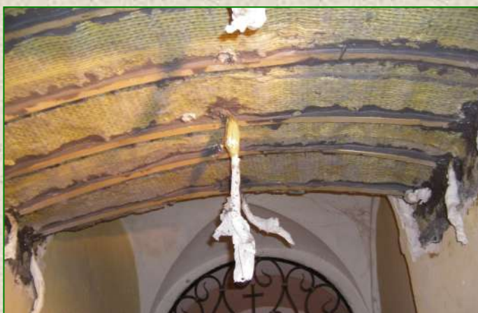
Rinforzo strutturale di piattabande presso la Chiesa di S. Benedetto in Fabriano (AN) (Anno 2009)
