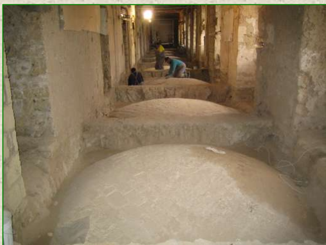
Consolidamento strutturale volte con utilizzo di materiali compositi in fibra aramidica presso l'ex Caserma Sacchi in Caserta (Anno 2006)
