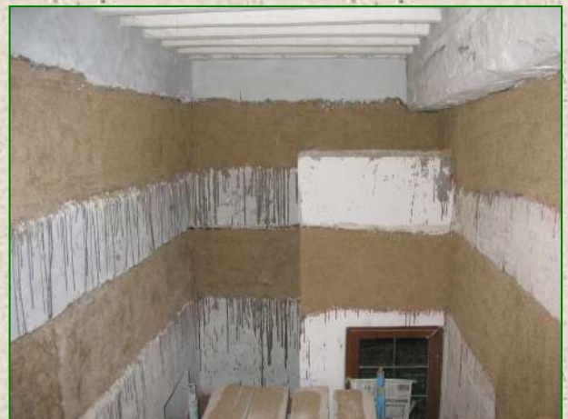
Intervento di consolidamento di pareti in mattoni del Monastero di Santa Margherita in Fabriano (AN) con utilizzo di materiali compositi in fibra aramidica (Anno 2007)
