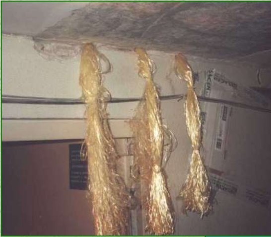
Lavori di applicazione di fibre aramidiche per il consolidamento statico della "Scala Serena" presso Palazzo Koch in Roma (Anno 2000)
