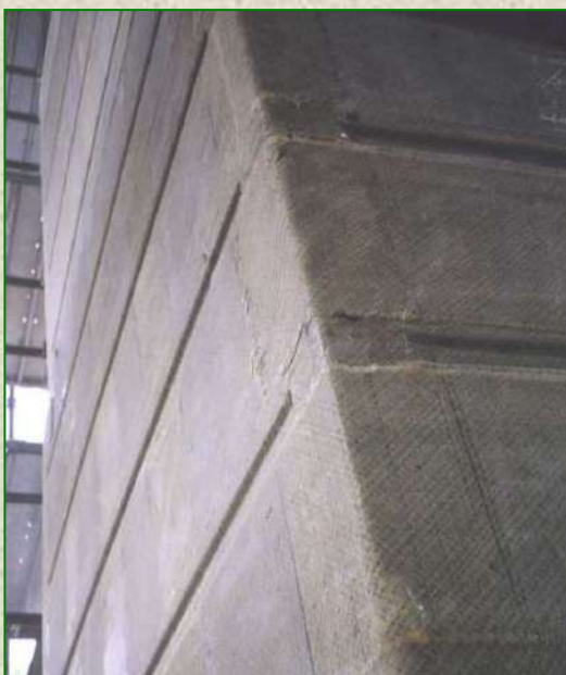
Lavori con impiego di materiali compositi a base di fibra aramidica e carbonio per la disarticolazione e rimozione della Stele Obelisco di Axum in Roma (Anno 2003)
