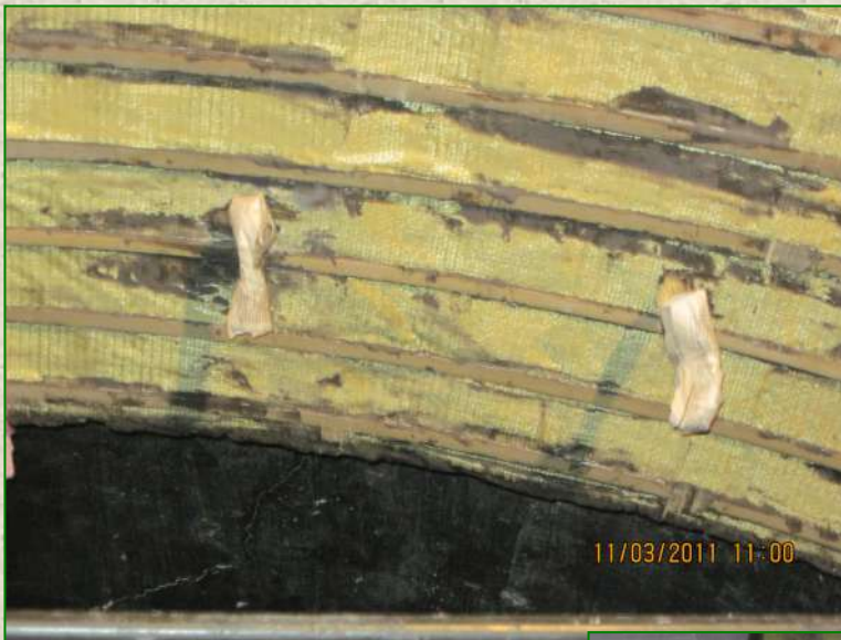
Lavori di rinforzo strutturale del Palazzo D'Avossa in Salerno mediante utilizzo di materiali compositi a base di fibra aramidica (Anno 2011)
