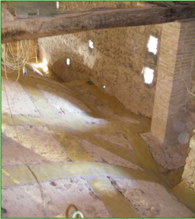
Lavori di consolidamento dell'impianto voltario della Chiesa S. Maria Assunta in Poggio Mirteto (RI) con utilizzo di materiali compositi in fibra aramidica (Anno 2007)
