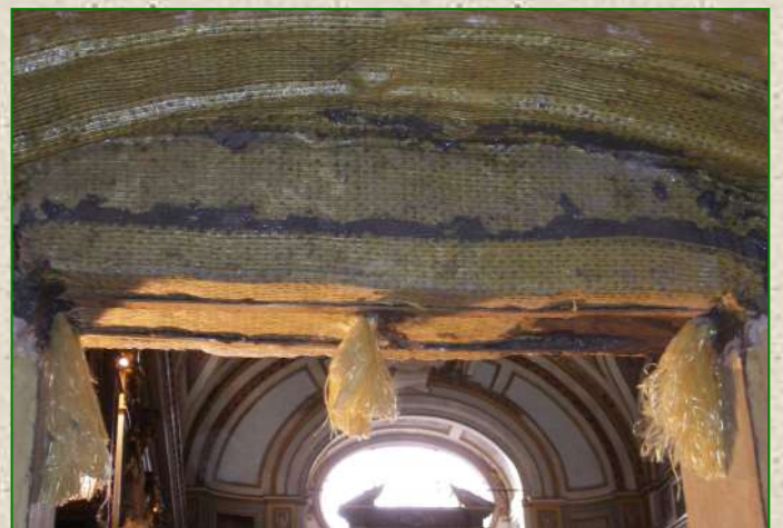
Rinforzo strutturale di piattabande presso la Chiesa di S. Benedetto in Fabriano (AN) (Anno 2009)
