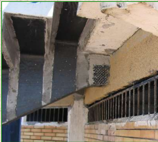
Lavori di consolidamento di struttura balneare in cemento armato con utilizzo di materiali compositi a base di fibre di carbonio – (Anno 2005)
