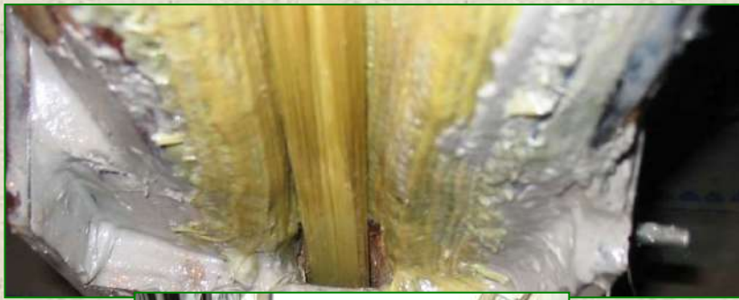
Consolidamento travi lignee nella Biblioteca di Storia Moderna e Contemporanea presso il Palazzo Mattei di Giove in Roma (Anno 2004)
