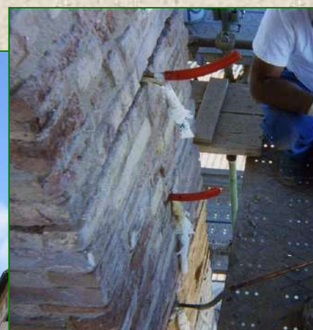
Lavori di consolidamento pilastri mediante utilizzo di materiali compositi presso la Torre Campanaria di Montalcino (SI) (Anno 2006)
