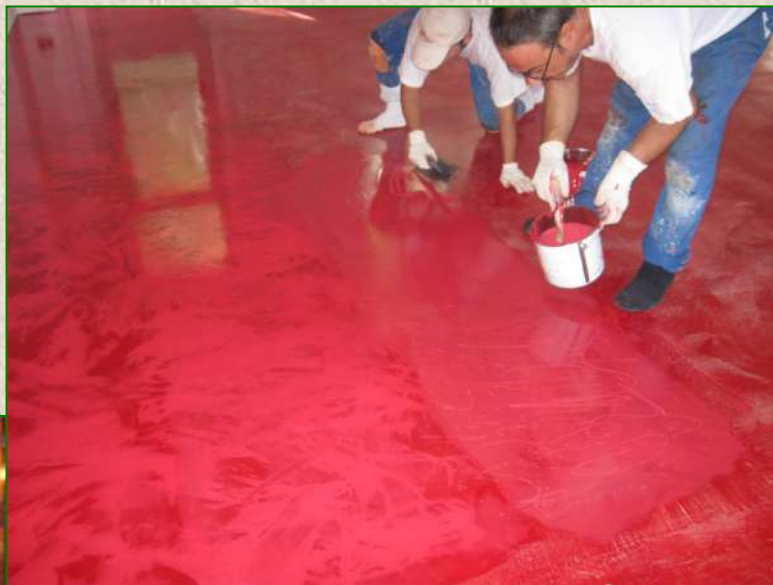
Esecuzione dei lavori di pavimentazione IPM ex Caserma Cosenz, Museo Civico di Gaeta (Anno 2009)
